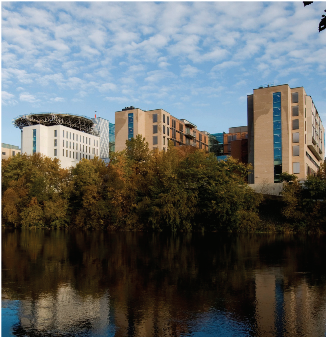
Figur 2: Bilde av det nye AHL-senteret ved St. Olavs Hospital. Den nye helikopterlandingsplassen på taket av hvitt bygg til venstre i bildet.
